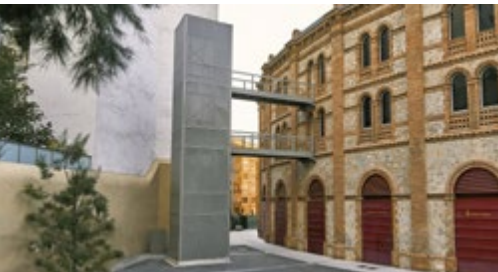
F Montacargas exterior. Exterior service lift.
