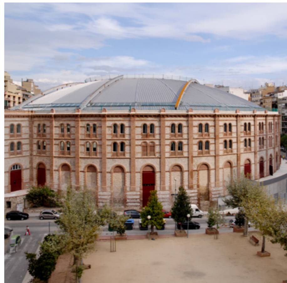
Acabat de la cúpula sense la part retràctil. Acabado de la cúpula sin la parte retráctil. Finished cupola without its retractable part.
