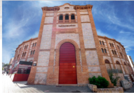
A Accés torrassa. Acceso torreón. Turret access.
