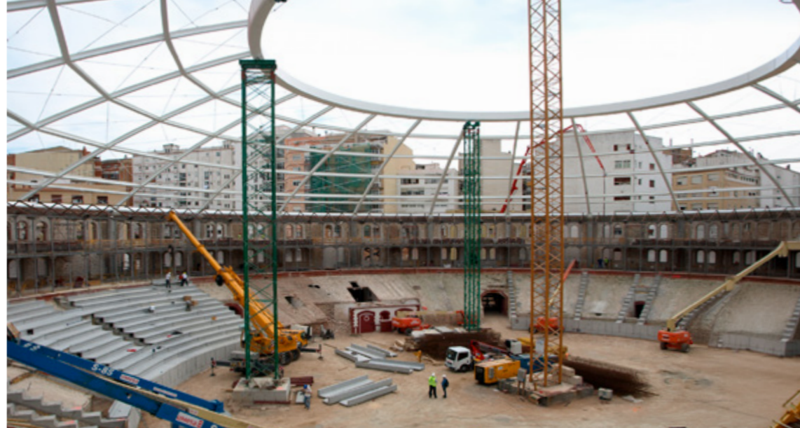
Construcció de la cúpula des de l'interior. Construcción de la cúpula desde el interior. Interior view of the construction of the cupola.
