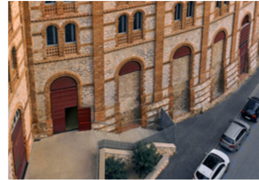
D Accés sales polivalentes. Acceso salas polivalentes. Multifunctional rooms access.
